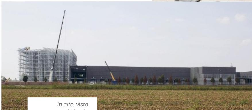
*In alto, vista del binario di trasporto interno che collega il nuovo magazzino a quelli preesistenti. Sopra, alcune fasi della costruzione del magazzino; in evidenza, la struttura portante degli scaffali interni.*
